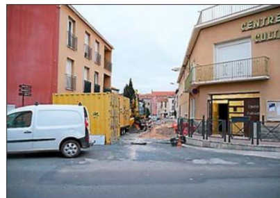
▶ Les travaux vont bon train dans la ville.
